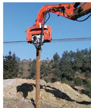
光伏建设 Photovoltaic construction
